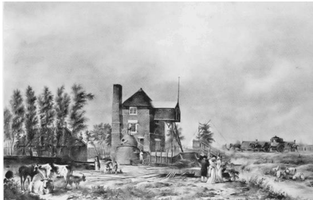
1790-N Primeur Met een nieuwe vorm van waterkracht de waterstand in de polder reguleren. Dat was tot voorkort nog niet vertoond in ons land. Een reden dus voor hoog bezoek al is het wat aan de late kant. Waar stond Neerlands eerste stoomgemaal?
